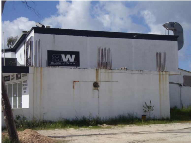
Εικόνα 5.35 Μισοτελειωμένο αντιαισθητικό κτίριο καφετέριας στο Λαγανά
