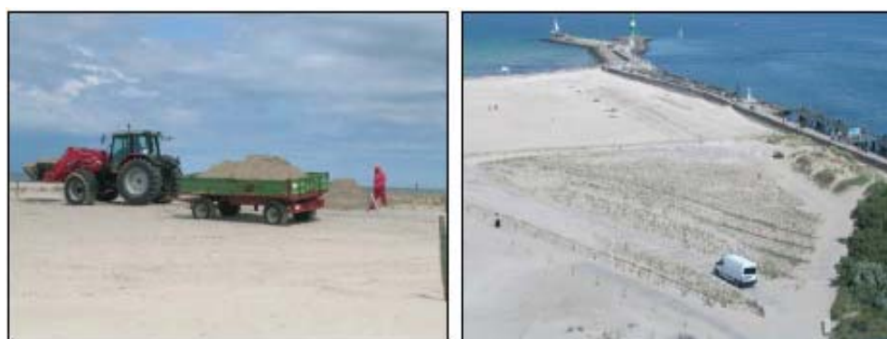
Εικόνα 4.20 Απομάκρυνση τμήματος αμμοθινών (αριστερά) και Ζώνη συσσώρευσης άμμου κατά μήκος του μόλου (δεξιά) Πηγή: Korfer, 2006
